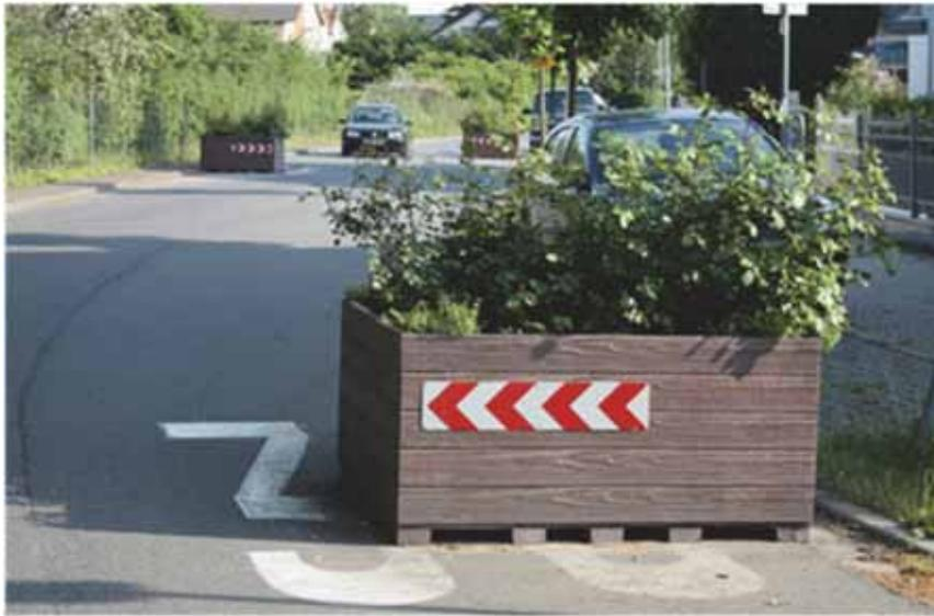
Mit Maserung wie bei Holz, Recycling-Kunststoff, aus Brettern 13,5x3,5 montiert, mit Alu-Winkeln verschraubt
